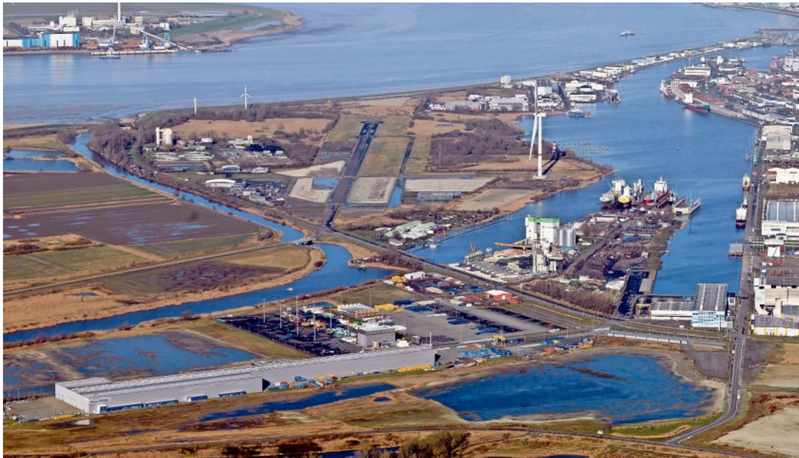
In Verlängerung der früheren Start- und Landebahn des Regionallughafens soll der Offshore-Terminal gebaut werden, aber der Baustopp gilt nun schon ein Jahr. Auf absehbare Zeit wird sich das Oberverwaltungsgericht auch nicht mit dem Verfahren beschäftigen. Mit dem für den OTB zurückgelegten Geld könnte der Bau einer Kaje im Fischereihafen parallel zum Flughafengelände finanziert werden.
